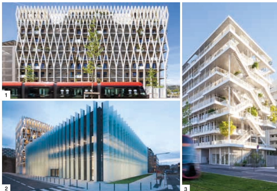
Des immeubles innovants et exemplaires comme Palazzo Méridia, plus haut bâtiment de bureaux en bois à sa livraison et premier bâtiment de bureaux labellisé E3C2. Ci-dessus : 1. Palazzo Méridia (Nexity - Architecte Architecturestudio). 2. IMREDD (Université Côte d'Azur - Architecte Atelier Barani). 3. Anis (Pitch Promotion - Architecte Laisné et Roussel)
